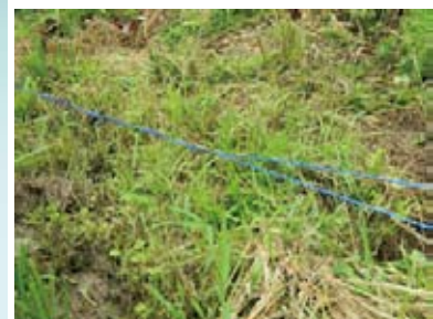
よじれた電線。正しく設置しなければ効果は無い。(泉区福岡)
